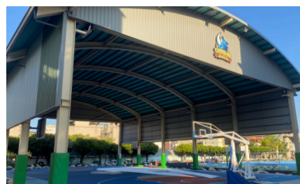
圖6-2-1 風雨球場增設照明設施
